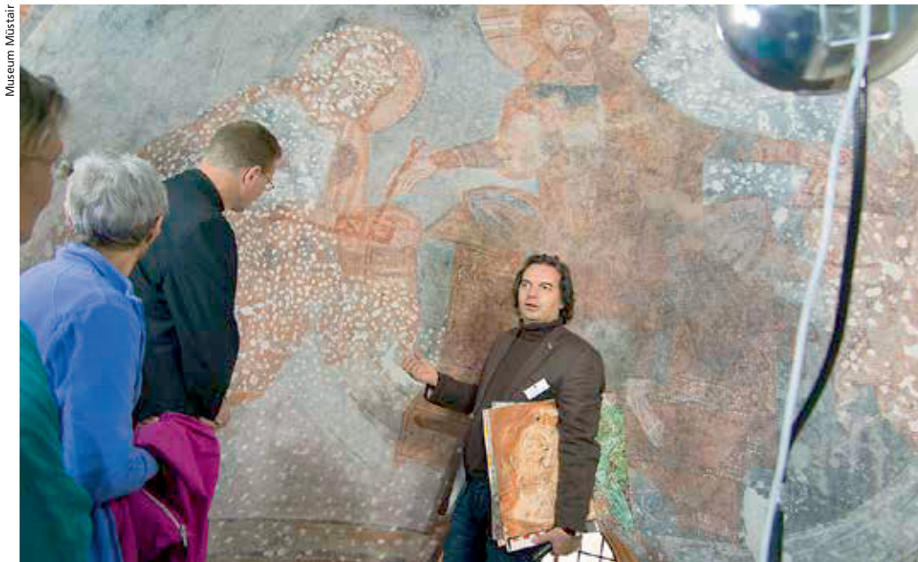
Restaurator Rufino Emmenegger auf dem Gerüst in der Nordapsis der Klosterkirche. Hier werden die Wandmalereien gereinigt und restauriert.
