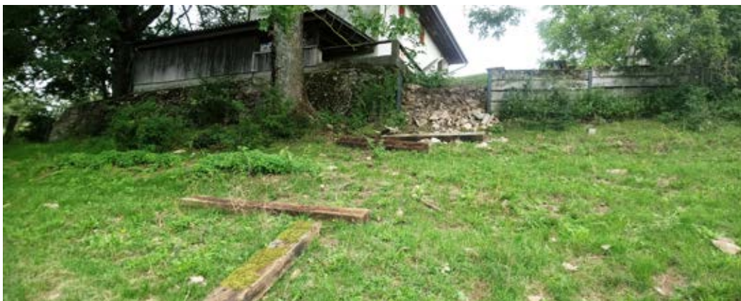
Die Balken der Stützmauer sind aus den Doppel T-Trägern gerutscht, wodurch sich das Geröll auf der Weide verteilt.
