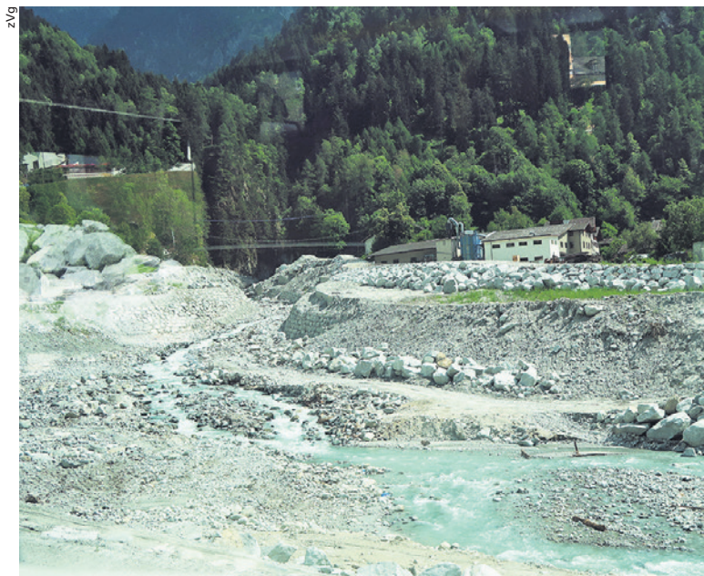
Blick aus dem Postauto im Juli 2018: Die Spuren des Bergsturzes und der Aufräumarbeiten sind deutlich zu sehen.
