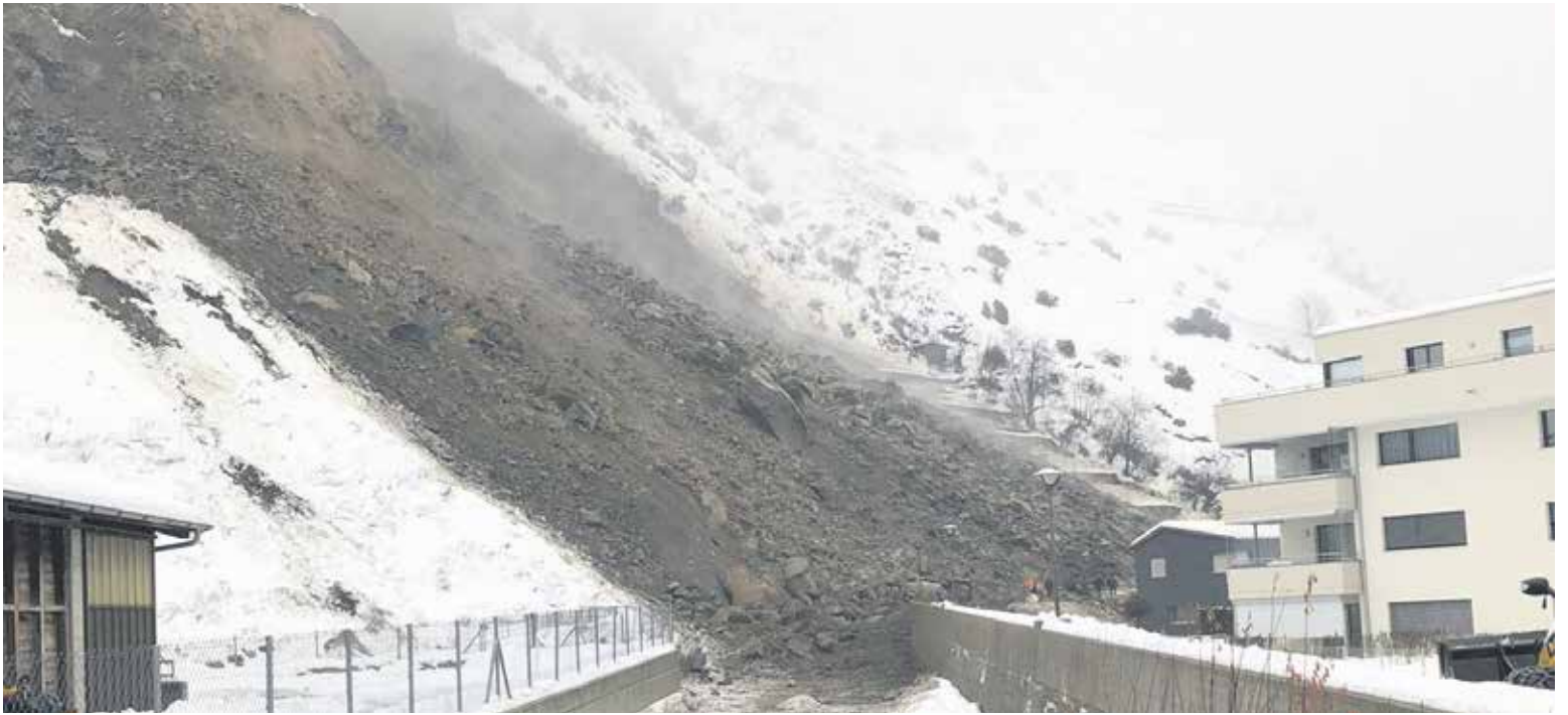
Ein Bruch – und vieles ist nicht mehr wie zuvor (Bild: Felssturz in einem Steinbruch in Raron VS, 29.1.2021).
