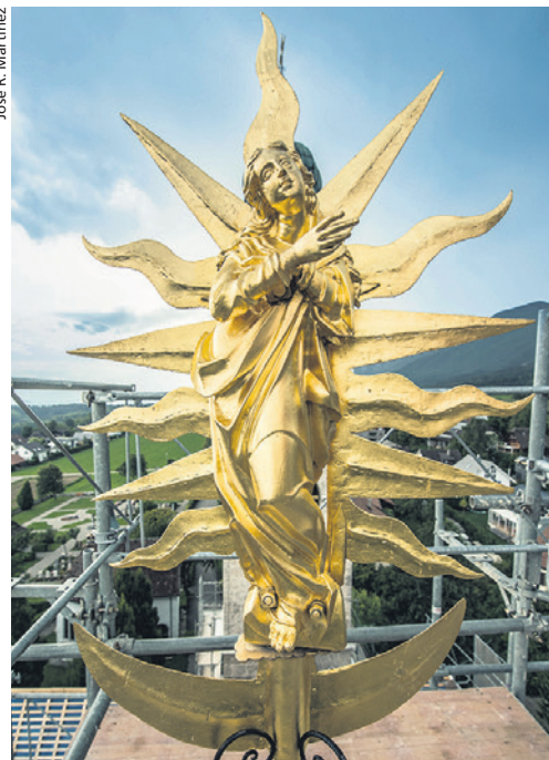
Dachreiter auf der Gnadenkapelle der Wallfahrtskirche Oberdorf.
