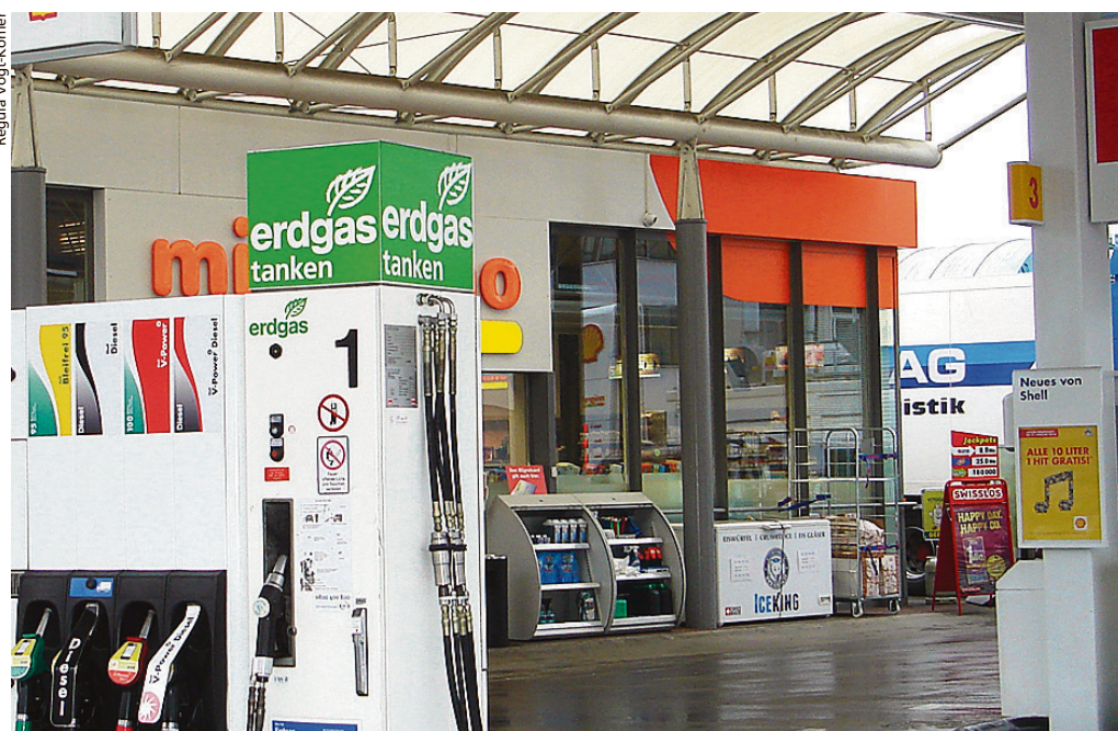
Tankstelle mit Laden in Allschwil.
