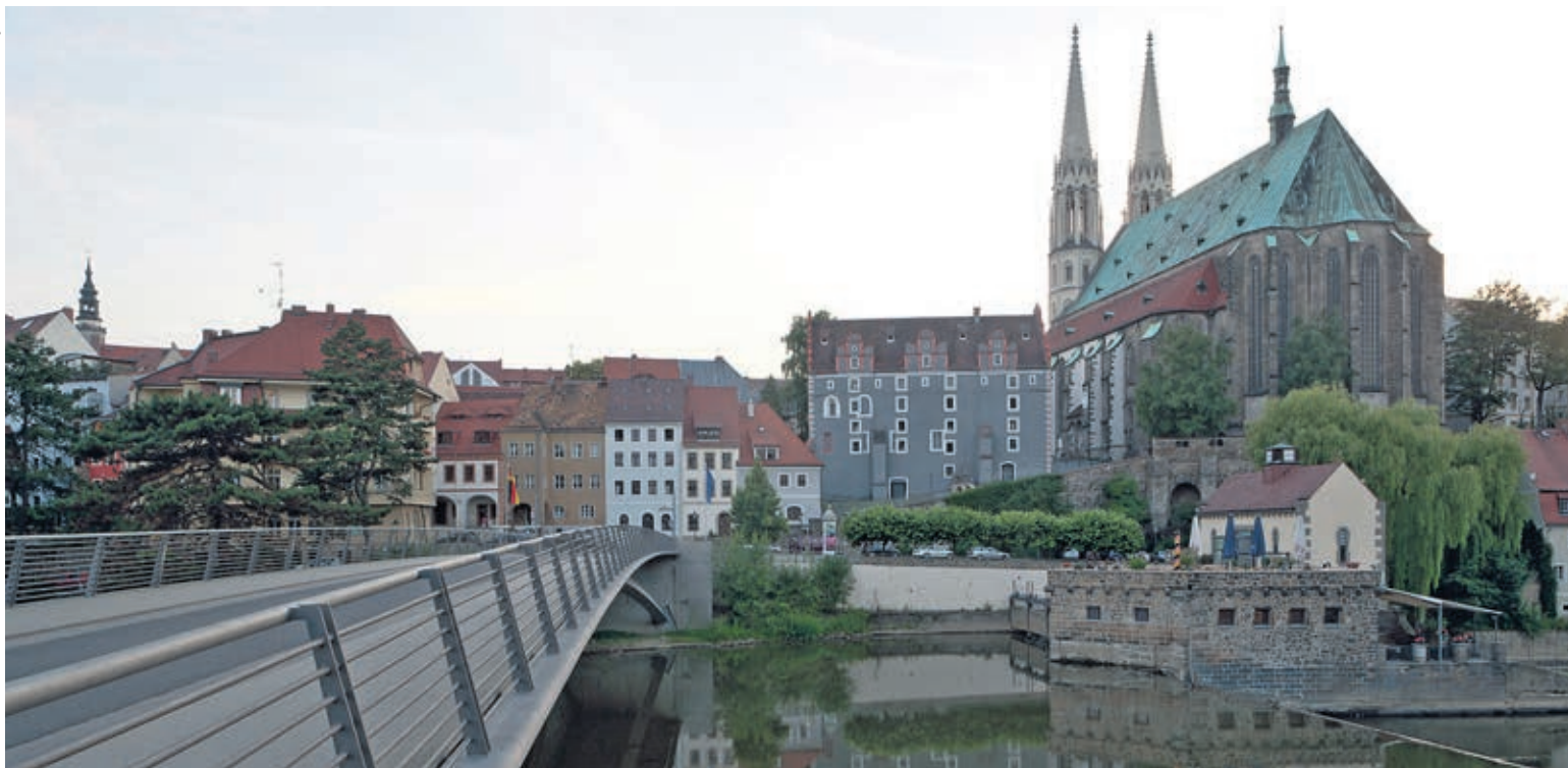
Die am Ende des Zweiten Weltkriegs zerstörte und 2004 neu erbaute Altstadtbrücke über die Neisse verbindet den deutschen und polnischen Teil von Görlitz/Zgorzelec. Die Heilige Hedwig wird als Heilige der Versöhnung zwischen Deutschland und Polen verehrt.
